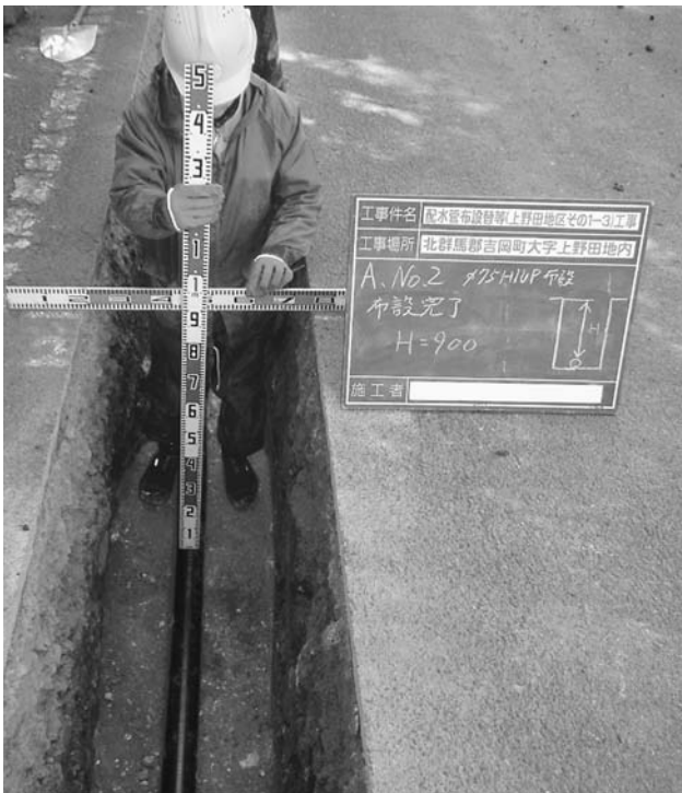
石綿管の布設替工事（上野田地区）
