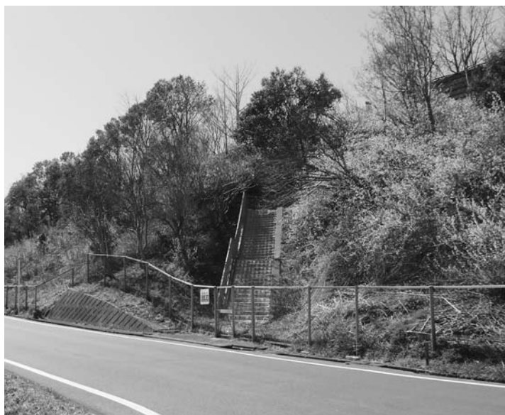
高速バス停用に設置されている階段
