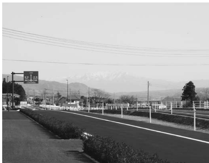
開通した高渋バイパス（上野田～小倉地内）
