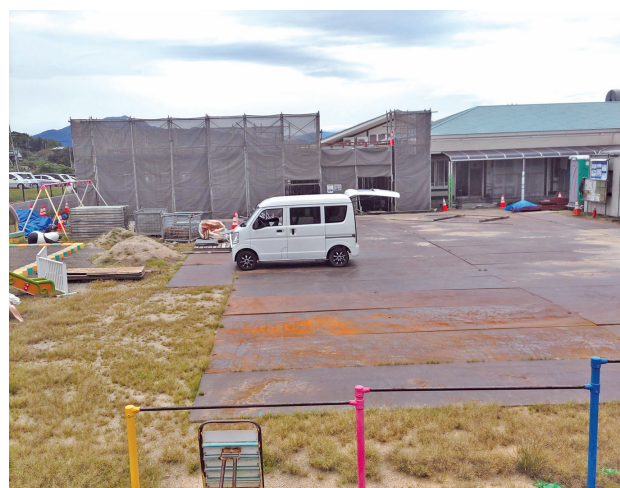
増築工事が進められている第一保育園
