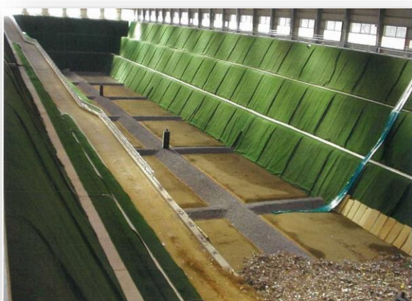
貯留施設内観
