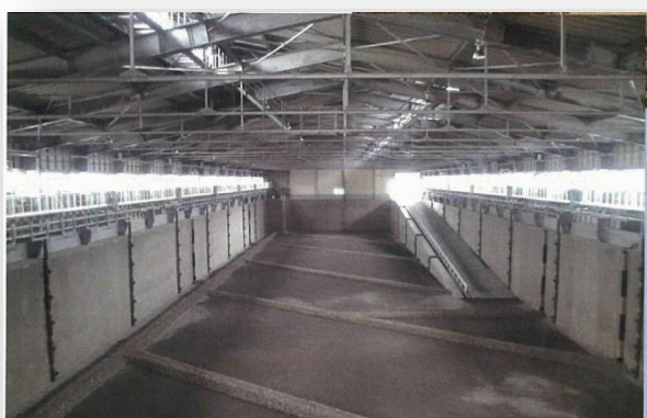
貯留施設内観
