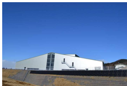
クローズド型最終処分場
