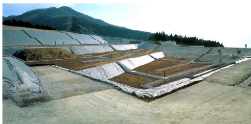
オープン型最終処分場
