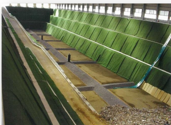
貯留施設内観
