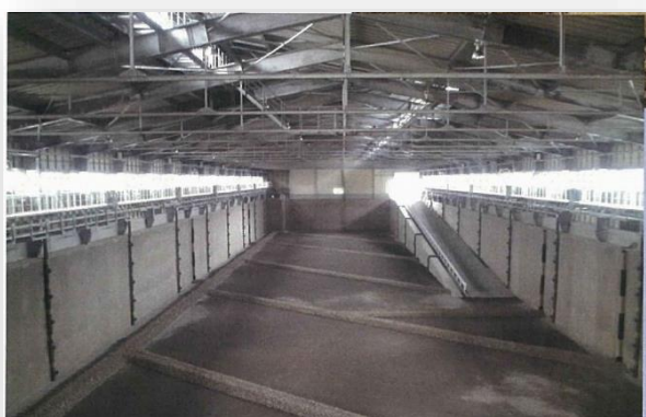
貯留施設内観
