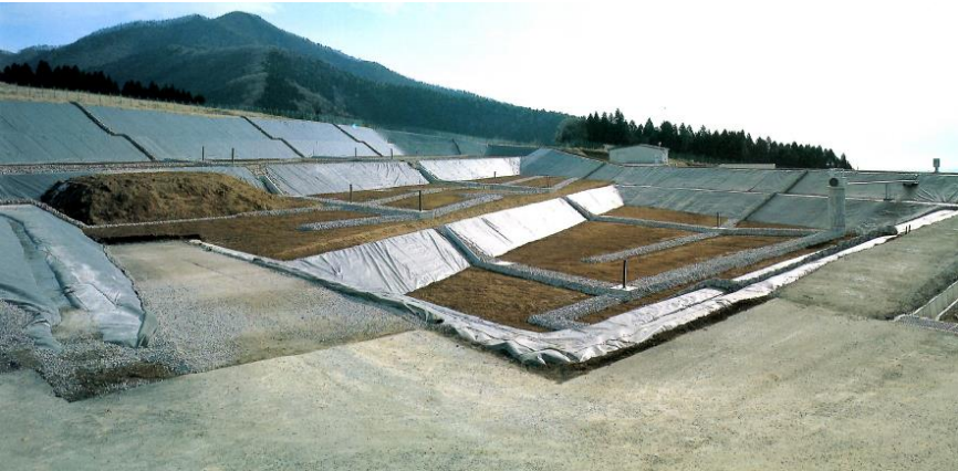
オープン型最終処分場
