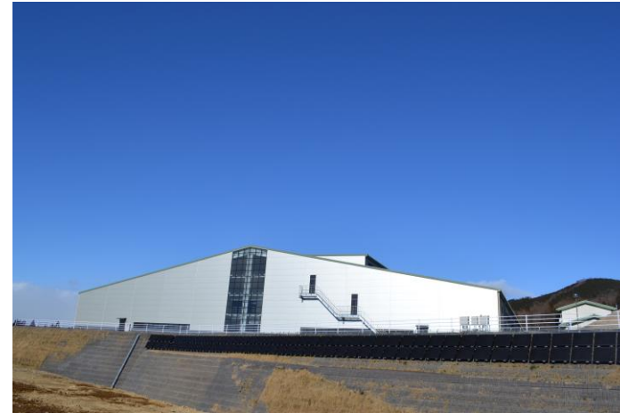
クローズド型最終処分場
